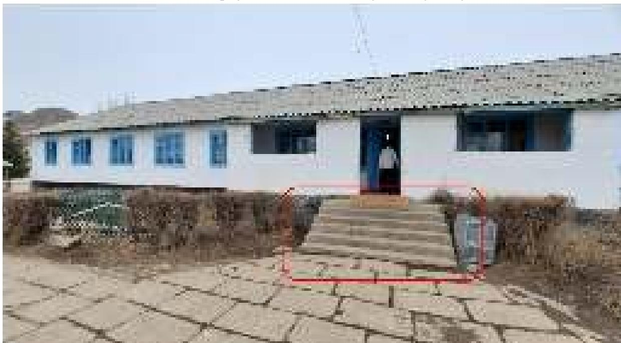
Фото 13. В корпусе №5 доступ ЛОВЗ ограничен, пандусы отсутствуют
