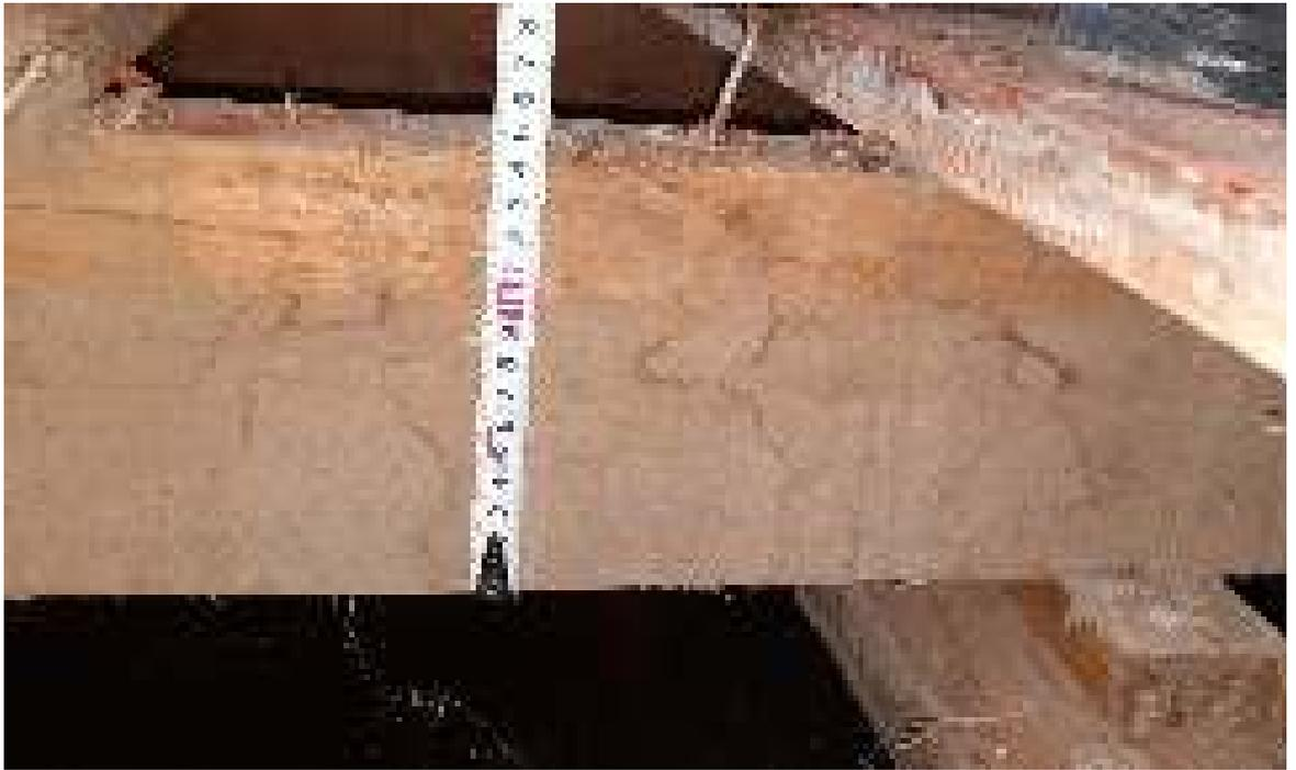
Фото 25. Сечение лаги 70x140 мм. Толщина половых досок 35 мм.
