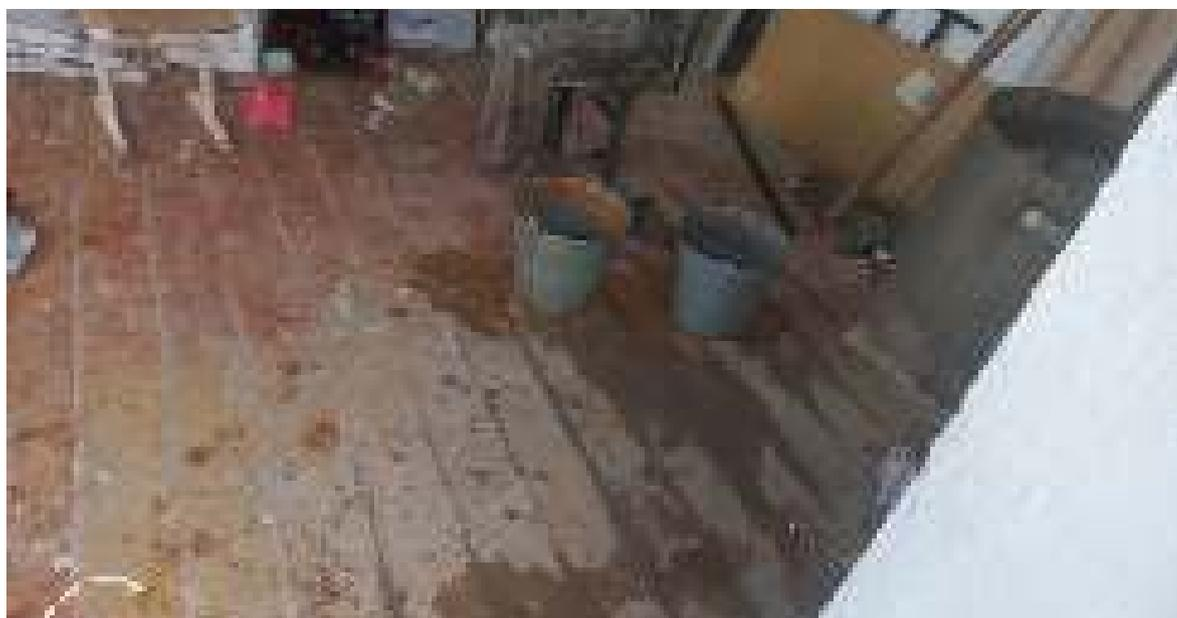
Фото 28 Фрагмент состояния пологового покрытия из дощатых досок корпуса №1
