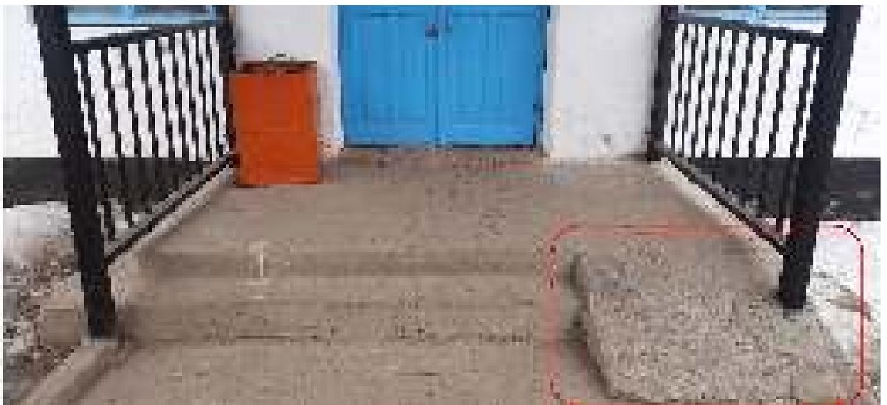
Фото 10. Только на главном входе в корпус №1 есть небольшой пандус, не отвечающим требованиям, нормам и стандартам СН КР 35-01:2018.
