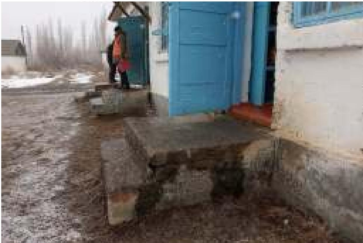
Фото 14. В корпусе №7 доступ ЛОВЗ ограничен, пандусы отсутствуют
