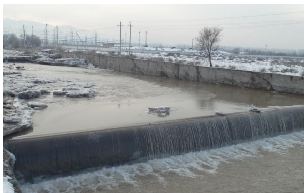
Фото 8. Пороги гасят скорость потока и способствуют накоплению воды
