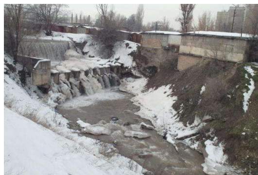
Участок эрозионного размыва русла реки Аламедин ниже железнодорожного моста
